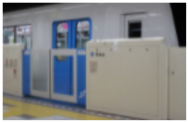
日本・札幌市の地下鉄 昇降ドアの段差を解消！
